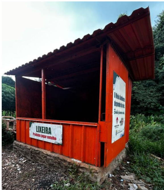
Figura 14. Casinhas de lixo na área rural
